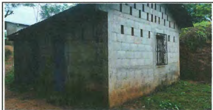
Foto 6: Repello en paredes area de cocina.
