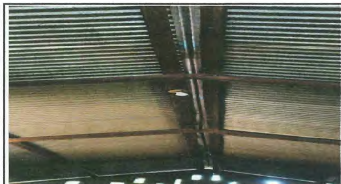
Foto 4: Instalación de lamina troquelada debido al deterioro de la lamina acanalada.
