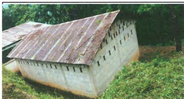
Foto3: Instalación de lamina troquelada al ambiente de nivel parvulos.
