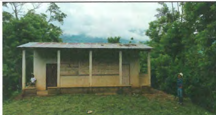
Foto1: Instalación de lamina troquelada al ambiente de nivel parvulos.
