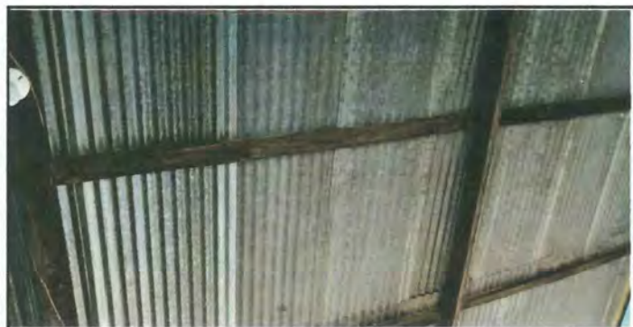
Foto 5: Instalación de costaneras (estructura de metal).
