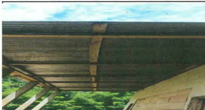
Foto 2: Instalación de estructura de metal para mayor durabilidad de la obra.
